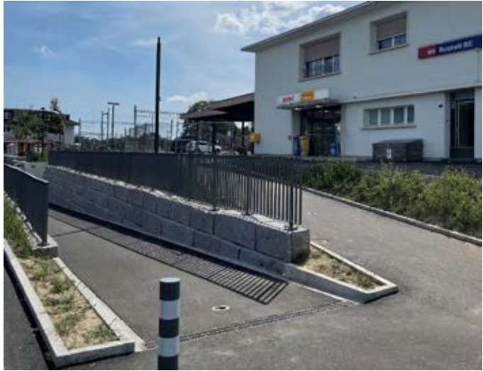
Der neue Zugang zu den Perronanlagen
